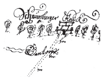
Durchlass mit Drehkreuzen an der Bückethaler Landwehr im 17. Jh.
